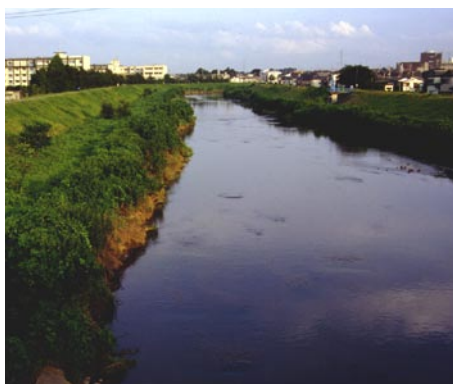
川 (新河岸川／袋橋より下流を望む)
