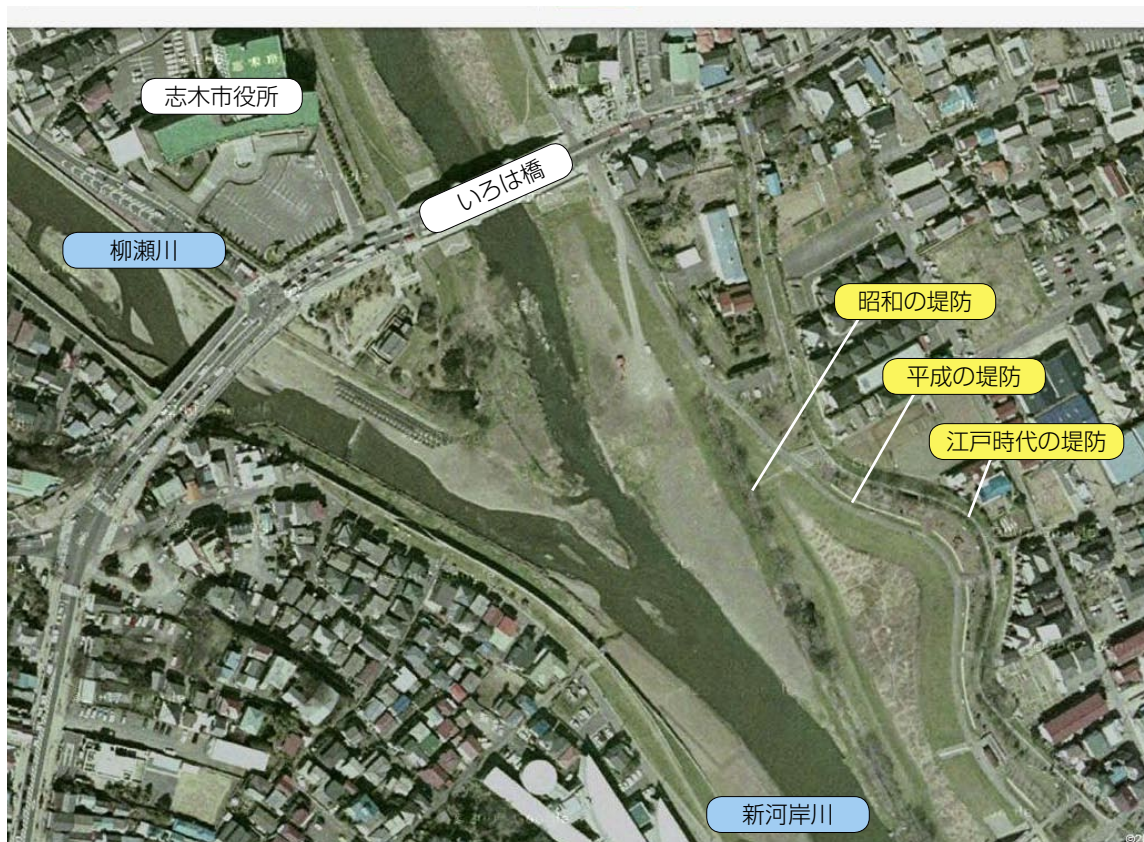
新河岸川沿いに現存する、江戸・昭和・平成の「三代の堤防」(google マップより)
