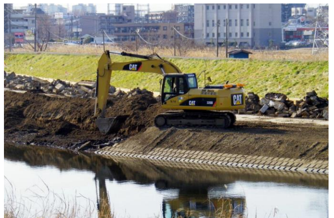
コンクリート護岸撤去工事
