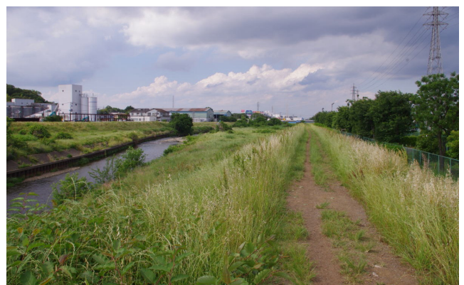
3. 河川敷開発の現場
