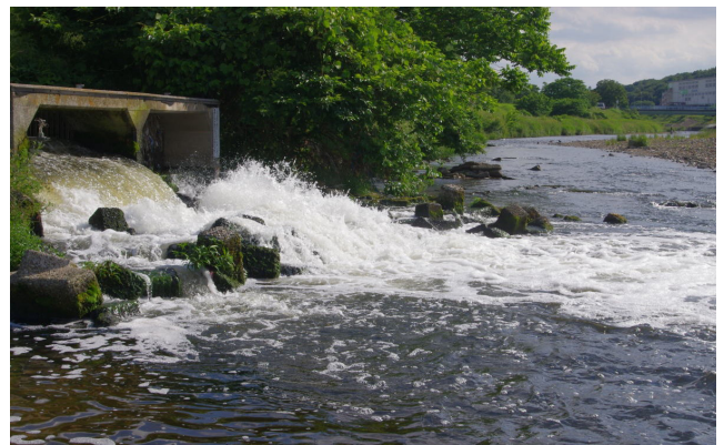
2. 水再生センターの放流口
