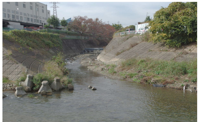
3. 流入する東川、奥に落差工が見える
