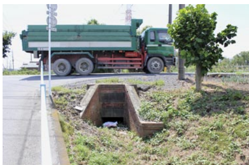
⑤ 新田場堤（下宗岡4丁目） 堤防の下に見えるのが、明治33年に煉瓦で修築された新田坎樋
