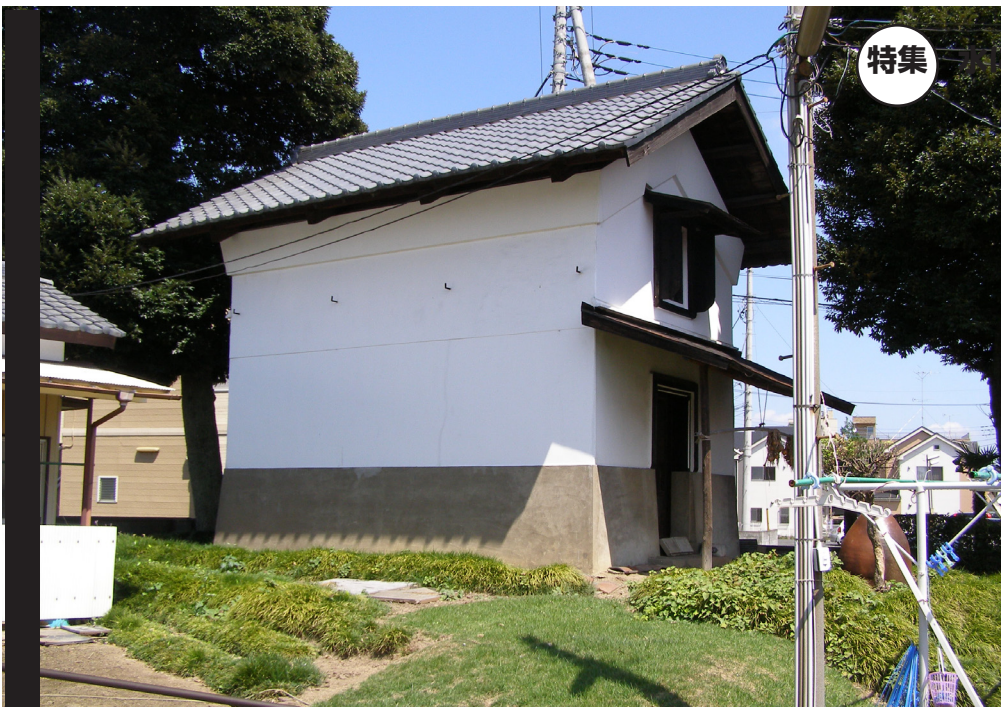
漆喰塗りの蔵（明治 28（1895）年築） 明治 43（1910）年の大洪水のときの水の跡が側壁のしたから 1.2 メートルの位置に残っていたそうです。作業小屋には避難用の舟がありました。
