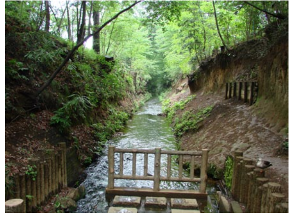
江戸へ多摩川の水を供給するために開削された玉川上水 玉川上水（1653）からさらに分水された野火止用水（1655）は、武蔵野台地を潤し、志木まで流れていました
