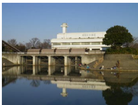
南畑排水機場
