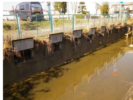
旧朝霞水路調整池の流入口
