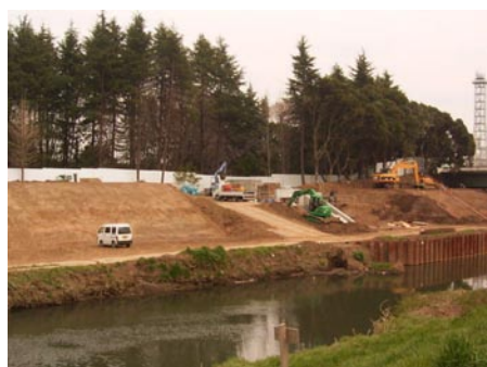
新河岸川の築堤工事
