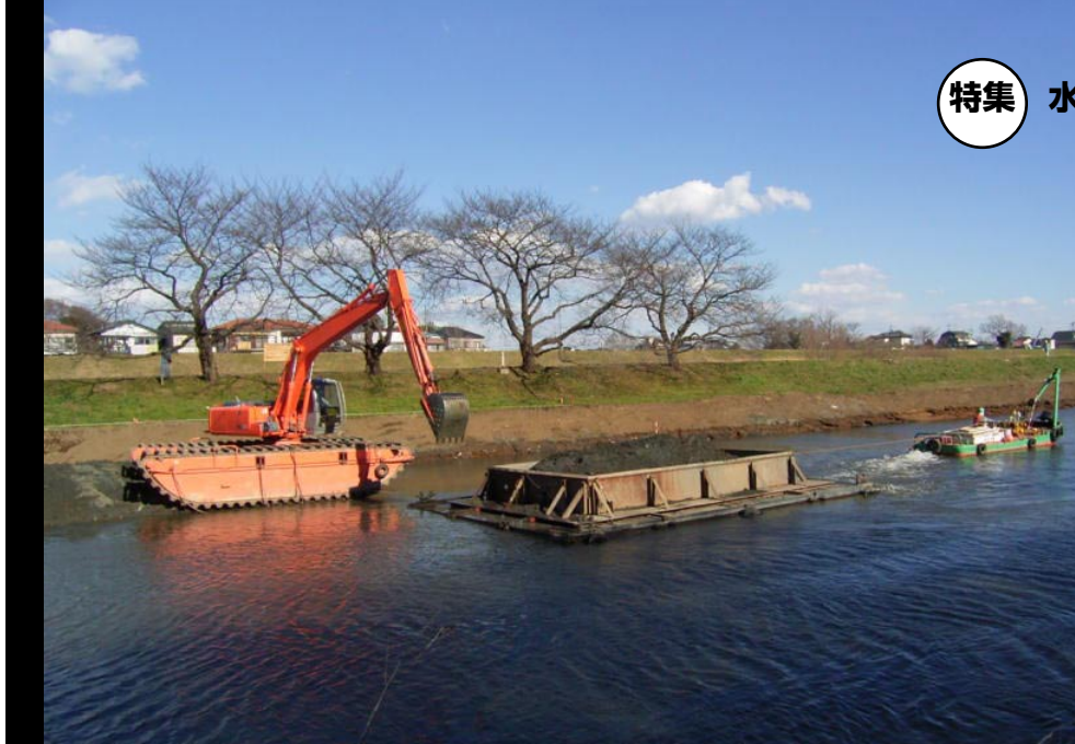
新河岸川の河床掘削
