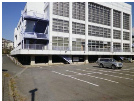
志木市民体育館調整池
