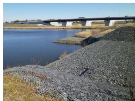
朝霞調節池の越流堤部分
