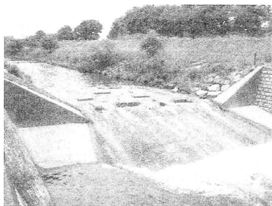
柳瀬川の上流・金山橋下流の落差工
