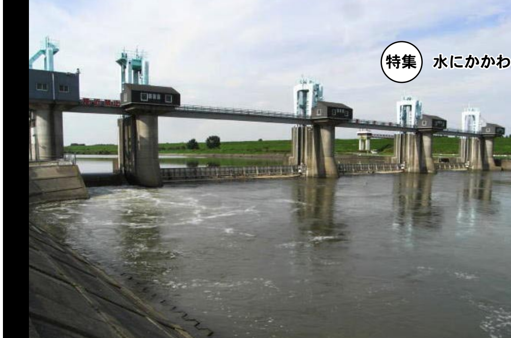
↑ 下流側から見た秋ヶ瀬取水堰。一番左が普段水を流している調節ゲート、その右が増水時に開放される三連の洪水吐ゲート、右端に魚道がある。
