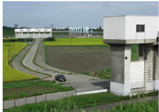
堤防から取水堰を望む。左奥が取水口、中央奥が取水堰、右手前が堤防を横切る樋管、道路の下に水路が埋まっている。
