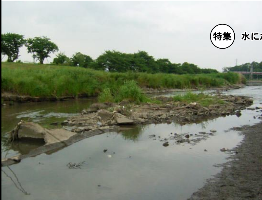
いろは橋下流の宗岡閘門解体跡の残骸
