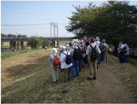
柳瀬川鉄橋を望む（10/7）
