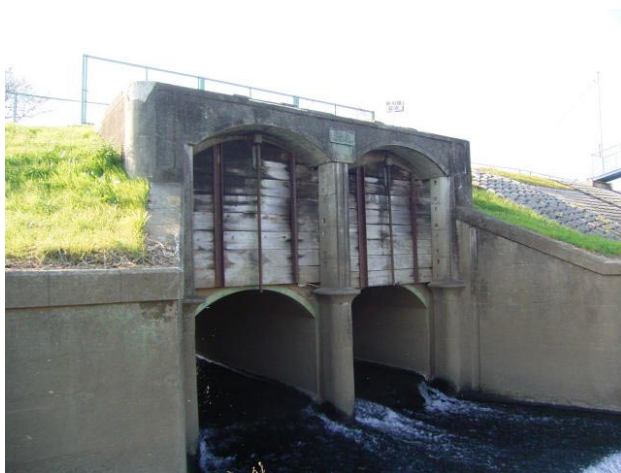
樋管や橋梁等の構造物で唯一現存する砂川堀合流点の砂川樋管（富士見市）
