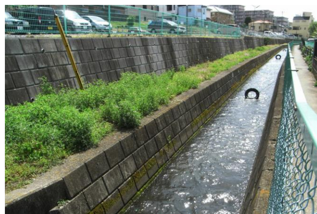
コンクリート三面張りの入間第二用水
