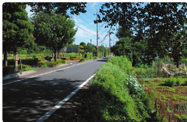
惣囲堤。今も道路などとして利用され現存している
