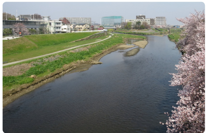
富士下橋から合流点付近を見る
